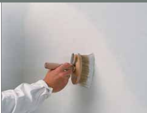
Работая штрихами крест-накрест, щеткой наносим содержащую кварц грунтовку Caparol-Putzgrund.
