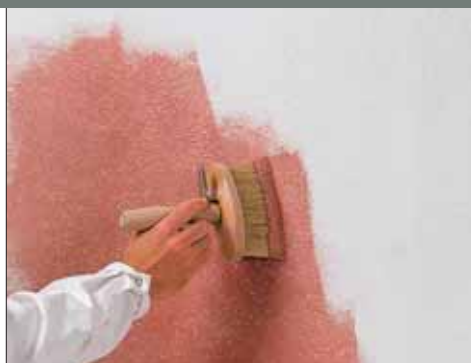
После высыхания делаем заключительное покрытие краской Arte-Lasur – короткими штрихами крест-накрест, щеткой.
