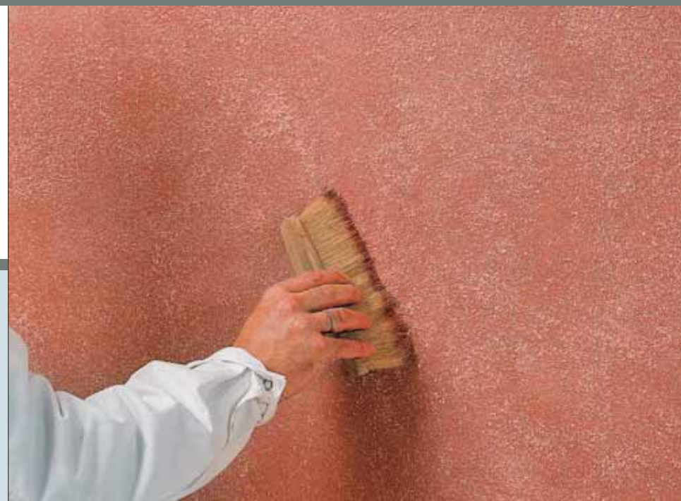
Через несколько минут поверхность обрабатывают мягкой щеткой, например, щеткой для удаления пыли. Это делает переходы более мягкими.
