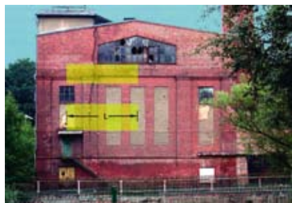
Рис. 6 Примеры оценки длины растяжения L кладки. Желтым цветом показана растянутая площадь кладки.
