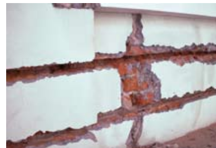
Рис. 3 Трещина в кладке, подготовленная для установки спирального анкера
